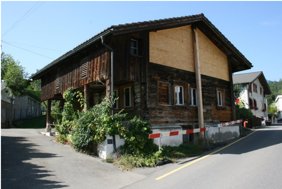
Holzhaus aus der Zeit um 1300, Mühlegasse 11 in Steinen. Vom Regierungsrat SZ zum Abbruch freigegeben. (Foto: Schweizer Heimatschutz)
