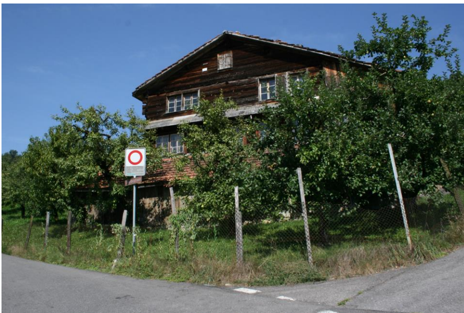
Holzhaus aus der Zeit um 1300, Lauigasse 19 in Steinen. Vom Regierungsrat SZ zum Abbruch freigegeben. (Foto: Schweizer Heimatschutz)
